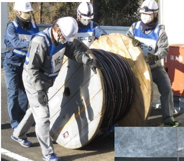
ケーブル敷設
