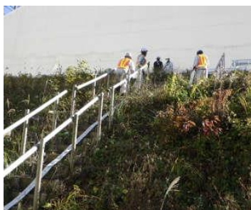
法面でのホース敷設
