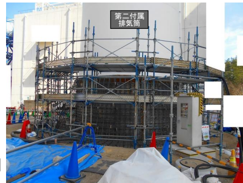
【第二付属排気筒耐震補強工事状況(基礎部の鉄筋工事)】
