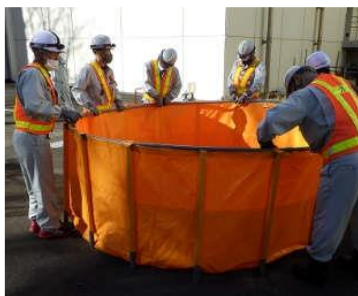
組立式水槽の設置
